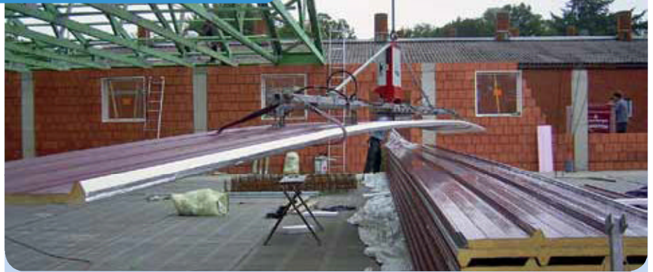
Der CLAD-BOY verfügt über eine Tragfähigkeit von bis zu 300kg.
