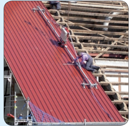
Bild 1 Fig. 1 Montage von Wandelementen beim Hallenbau mit einem CLAD-BOY Installation of wall elements for factory construction using a CLAD-BOY
